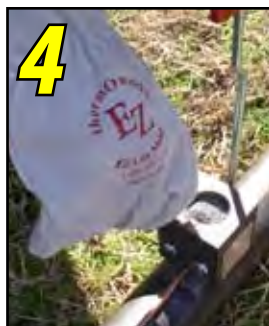
4 Pour weld metal into mold.
